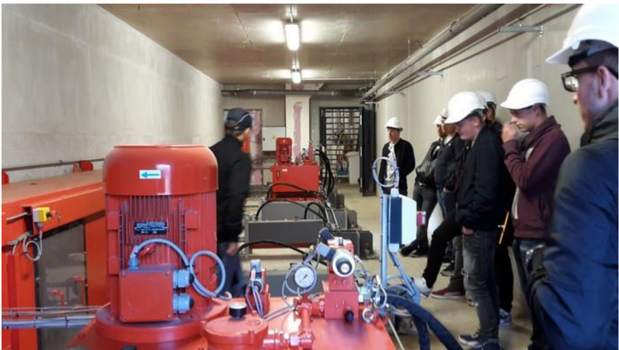
Début de la visite : mécanisme d'introduction des plaquettes de bois sur la vis sans fin.
